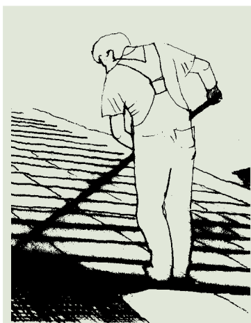
Målningsarbetet utförs med fördel vid ihållande vackert väder och hellre på försommaren än på eftersommaren, då daggen kan vara besvärande.
